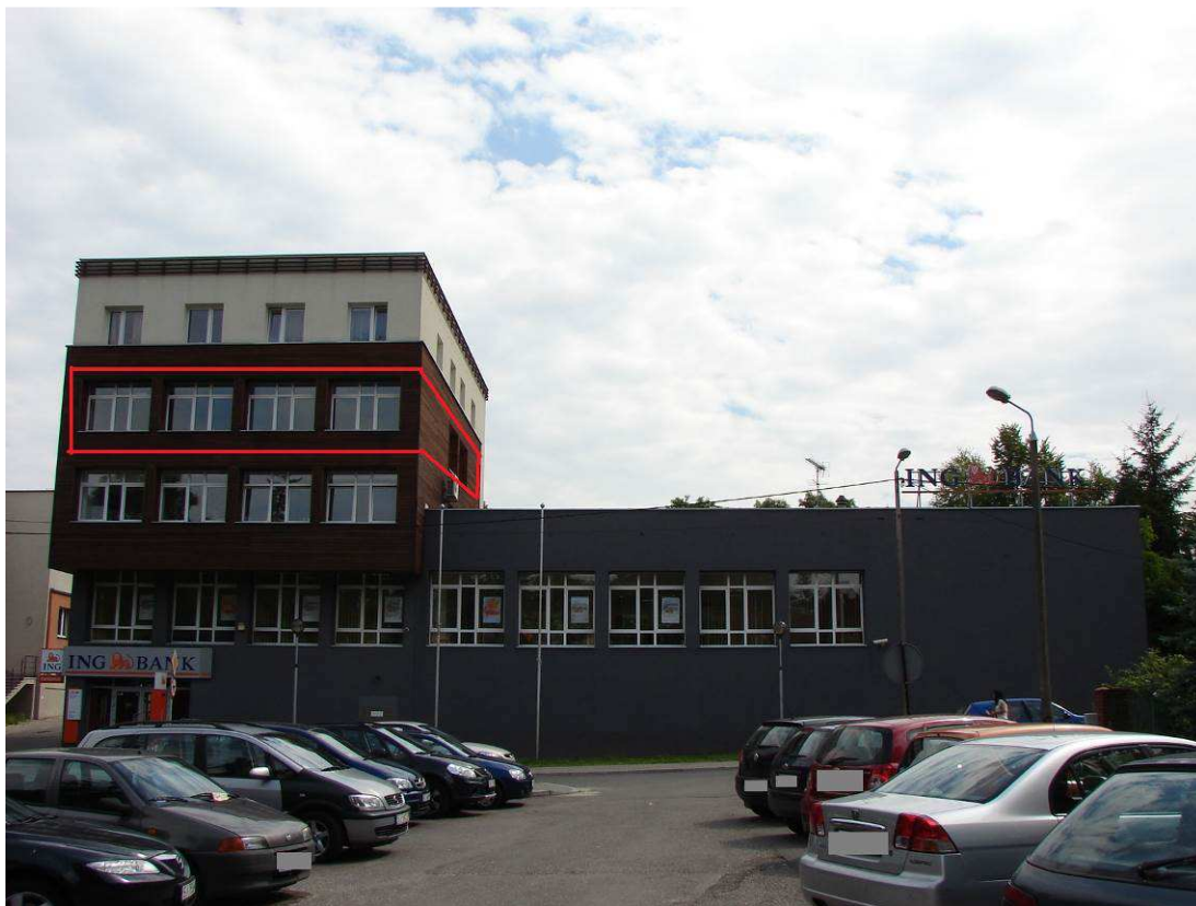
Zdjęcie nr 1. Budynek – elewacja frontowa. Widok z parkingu ogólnodostępnego.
